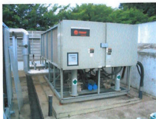
Figura 8b – Chiller da CAG 02 com 90 TR.
