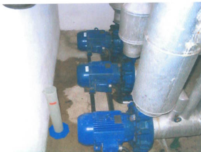
Figura 9 – Bombas de água gelada da CAG 02.
