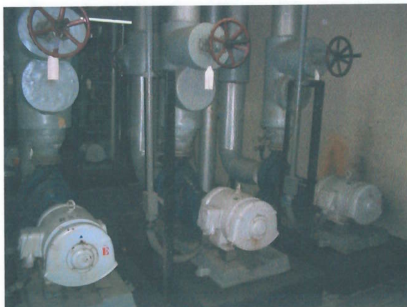
Figura 4- Estado das bombas de água gelada da CAG 01.
