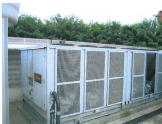
Figura 8a – Chiller da CAG 02 com 80 TR.
